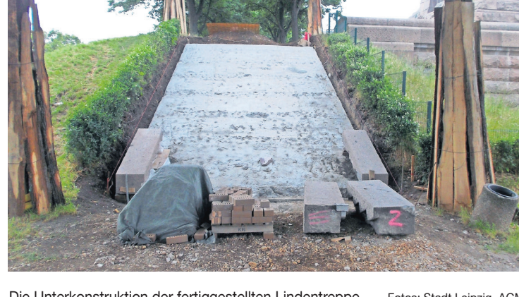
Die Unterkonstruktion der fertiggestellten Lindentreppe. Fotos: Stadt Leipzig, AGM
