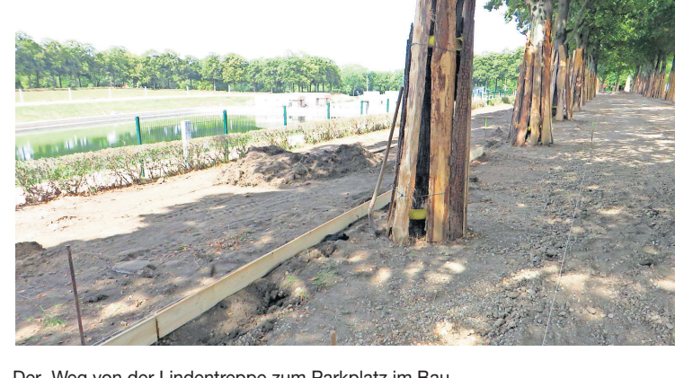
Der Weg von der Lindentreppe zum Parkplatz im Bau.
