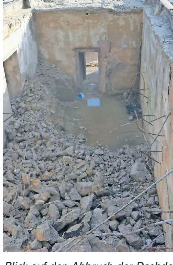
Blick auf den Abbruch der Dachdecke Kopfbau West im Juli 2015.
