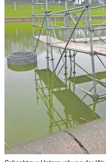
Schacht zur Untersuchung der Wasserbeckensohle im Dezember 2015.
